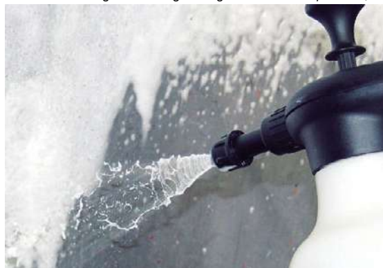
Reiniger schaumig auftragen mit Schaumprüher 1,5 l.
