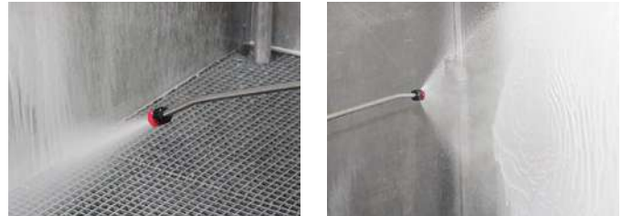
Reiniger auftragen mit Druckluft-Schaumlanze
